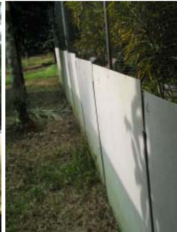
ผนังด้านข้างบุด้วยกระเบื้องแผ่นเรียบ
